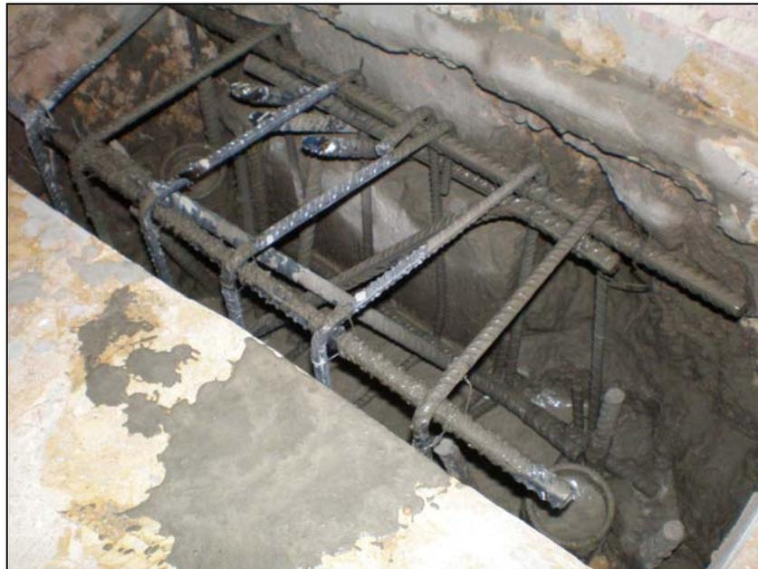
**ENCEPADO DE MICROPILOTOS Y CONEXIÓN A CIMENTACIÓN EXISTENTE.**
