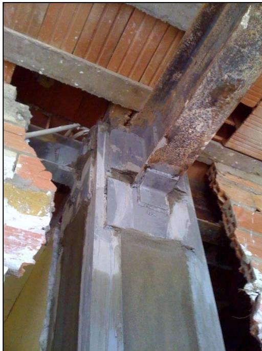
**PILAR RECONSTRUIDO CON MORTERO TIXOTRÓPICO DE RESISTENCIA A COMPRESIÓN= 50 N/mm<sup>2</sup>, Y EMPRESILLADO CON ACERO LAMINADO.**
