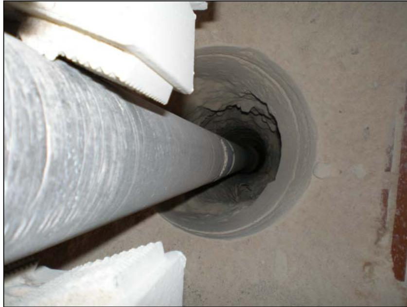
**PERFORACIÓN SOBRE CIMENTACIÓN EXISTENTE HASTA COTA -8m.**
